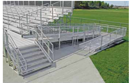
ADA ACCESSIBLE RAMP
